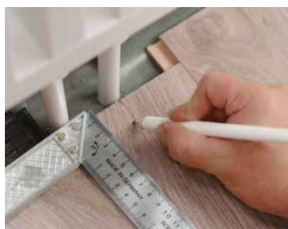
Ajtókeret és radiátor csövek
